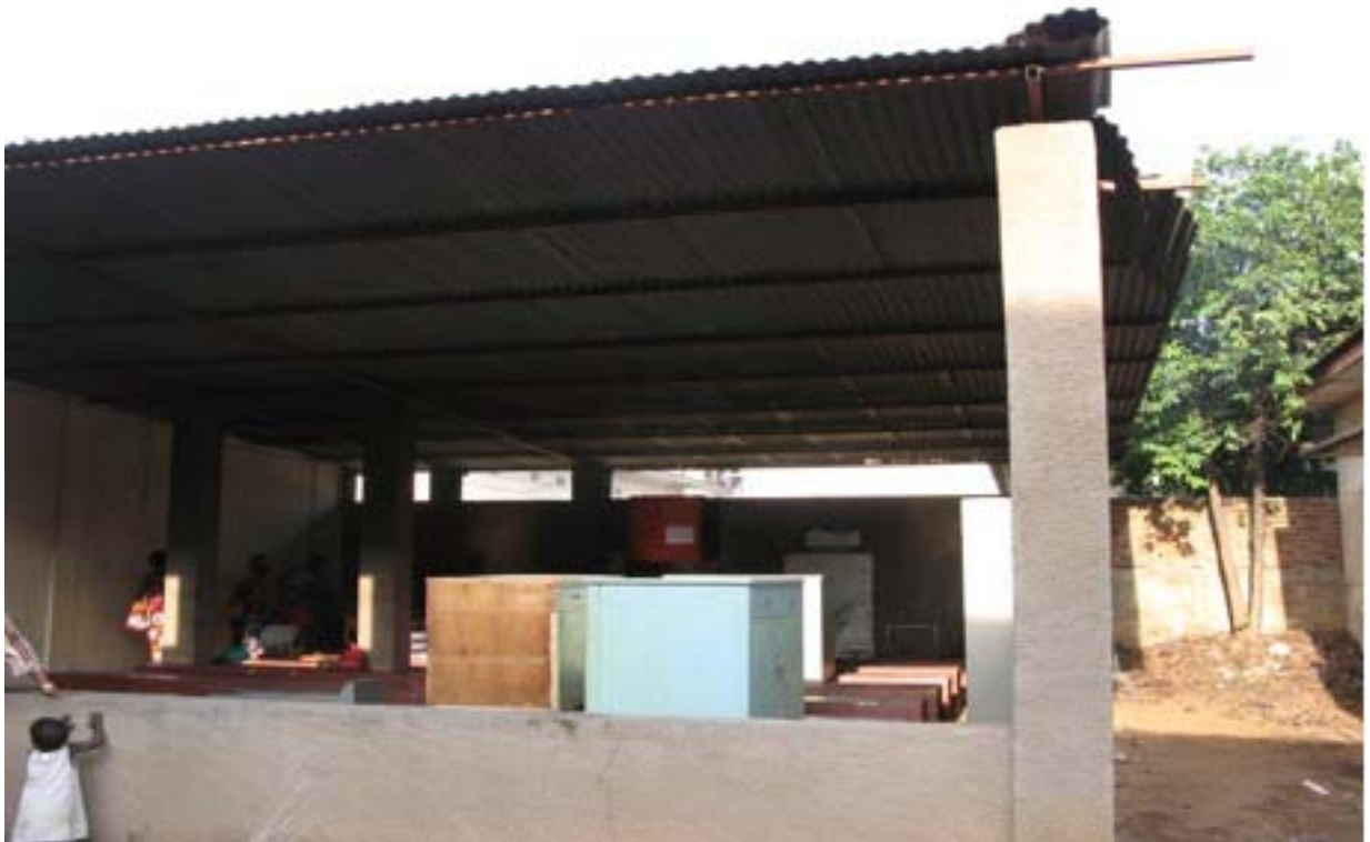
Photo 1 : février 2010 : bâtiment avant les travaux
